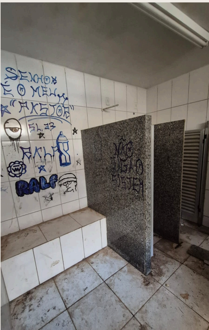
Imagem do banheiro da quadra antes da reforma. Janeiro, 2026
